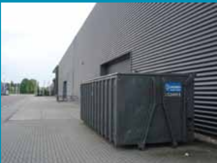
Containers tegen het gebouw plaatsen blijven gevaarlijk. Deze is gelukkig afgesloten en de inhoud niet gemakkelijk in de brand te steken.
